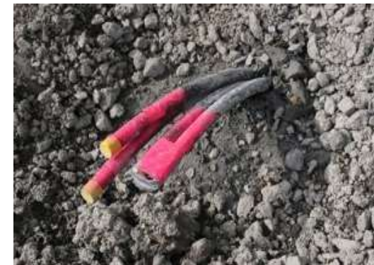
Oberes Ende einer Erdsonde
