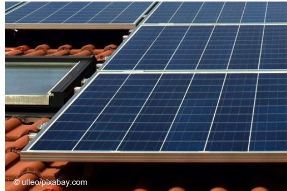
Solarmodul mit 60 polykristallinen Solarzellen
